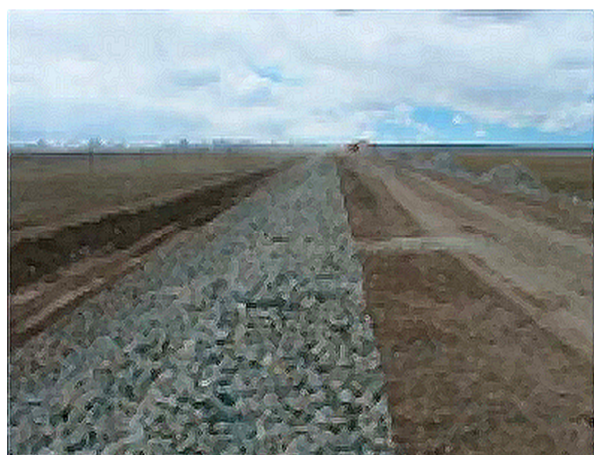
Рис. 8. Технологические приёмы охлаждения мёрзлых пород, используемые при строительстве Цинхай-Тибетской железной дороги [Wu Qingbai et al. 2008]: дроблёный камень в покрытии (слева) и насыпи (справа)
