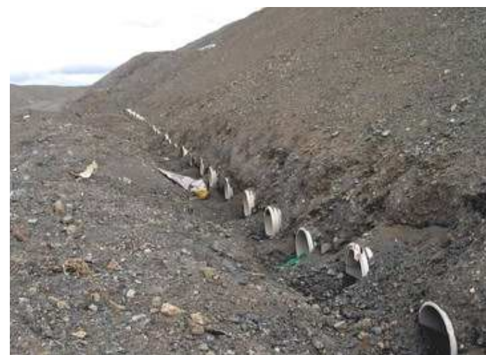
Рис. 9. Откос щебневой насыпи на участке Цинхай-Тибетской железной дороги в районе горы Фэнхошань (4800 м) с вентиляционными трубами, позволяющими холодному воздуху циркулировать под железнодорожным полотном. Фото с сайта https://ru.pinterest.com/pin/382031980864033798/
