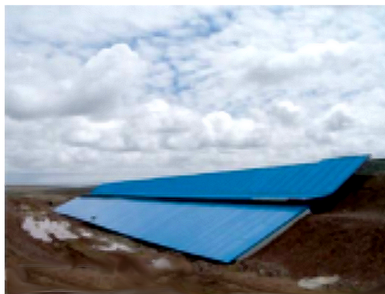
Рис. 10. Технологические приёмы охлаждения мерзлых пород, используемые при строительстве Цинхай-Тибетской железной дороги [Wu Qingbai et al. 2008]: термосифоны (слева) и солнцезащитные навесы (справа)
