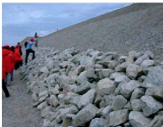
Рис. 8. Технологические приёмы охлаждения мёрзлых пород, используемые при строительстве Цинхай-Тибетской железной дороги [Wu Qingbai et al. 2008]: дроблёный камень в покрытии (слева) и насыпи (справа)
